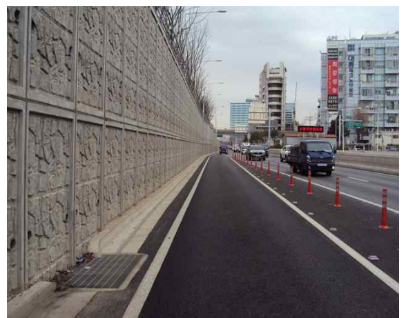
중점측 하부 전경
