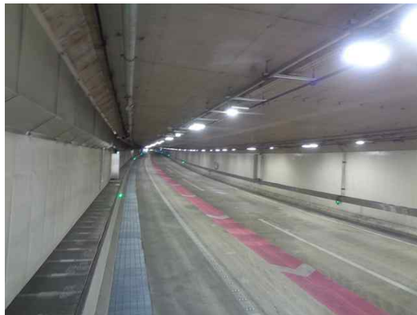
서부간선지하도로 내부 (BOX구간)
